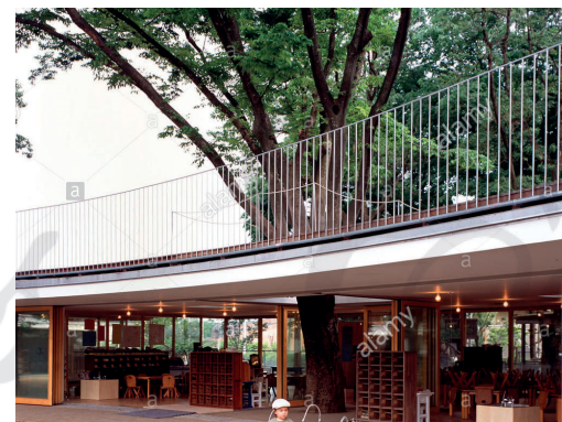
7. ASILO GIAPPONESE PROGETTATO DALL'ARCHITETTO TAKAHARU TEZUKA, CHE CONSENTE ALL'ALBERO DI CRESCERE ATTRAVERSO LA STRUTTURA
