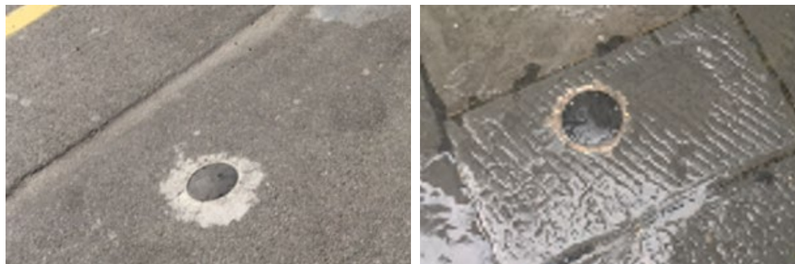
figura 34 – Sensori per stallo merci installati in differenti pavimentazioni stradali
