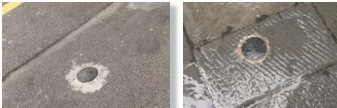
*figura 36 – Sensori per stallo merci installati in differenti pavimentazioni stradali*
