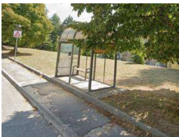
Figura 34 – Fermata in Via Antica Arischia, risulta inadeguata per assenza di rampa per le persone a mobilità ridotta
