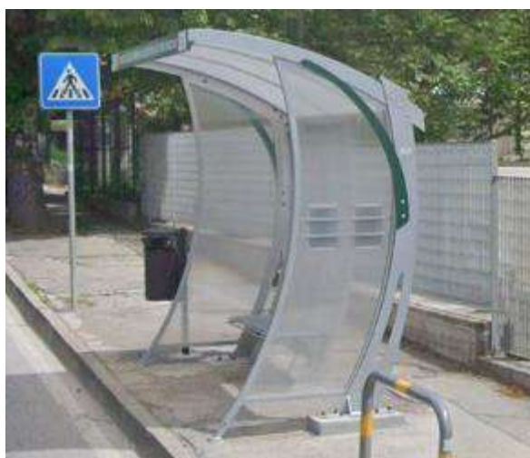
Figura 33-Fermata in Viale della Croce Rossa; risulta inadeguata in quanto inaccessibili a persone con mobilità ridotta
